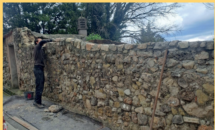
Réfection d'un mur de soutènement
