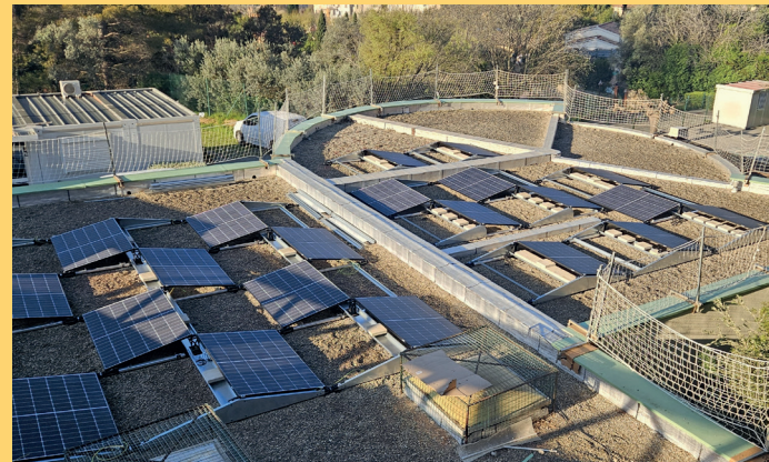
Pose de panneaux photovoltaïques sur le toit de l'école
