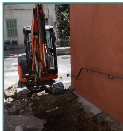
Assainissement Calade rue Font Giraude
